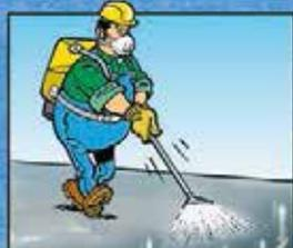
SE UTILIZAR COMPOSTOS DE CURA, APLICÁ-LOS HOMOGENEAMENTE E REPETIR SE NECESSÁRIO.
