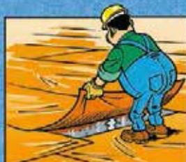
COLOCAR COBERTURAS OU MEMBRANAS DE CURA COM SOBREPOSIÇÕES ADEQUADAS, E PROTEGER OS BORDOS CONTRA OS LEVANTAMENTOS POR AÇÃO DO VENTO.
